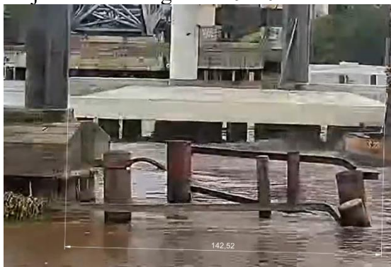
Gambar 10. Lebar Pilecap Pier 3 berdasarkan dokumentasi video CCTV
